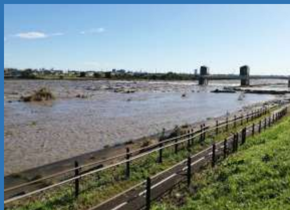
増水した多摩川（宿河原堰付近 令和元年10月13日）
