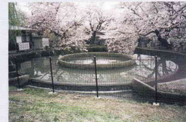
▲ 高津区久地にある円筒分水
